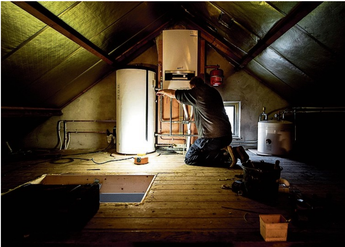
EEN INSTALLATEUR PLAATST EEN WARMTEPOMP. ANP
